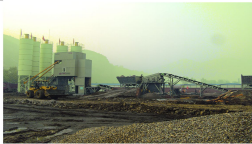
▲ 承德路桥施工现场
