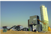
▲ 浙东高速公路施工现场
