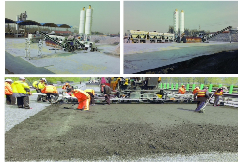
▲ 搅拌好的成品料施工现场
