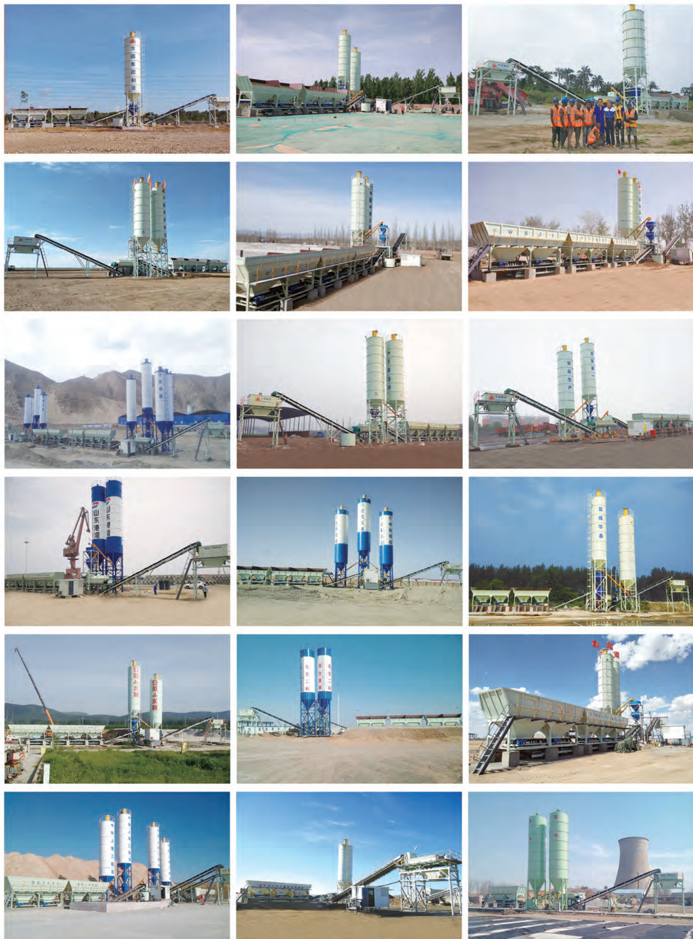
▲ 改良土拌和站
