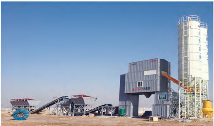
▲ 浙东高速施工现场
