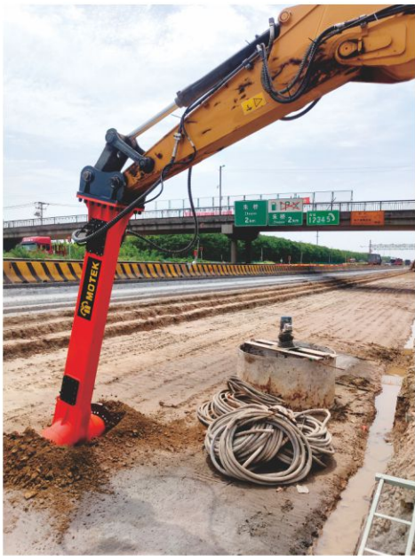
高速路拓宽底基层固化
