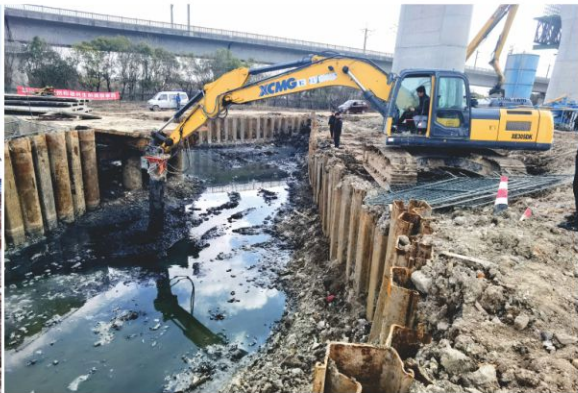
非正规垃圾填埋场污染底泥固化
