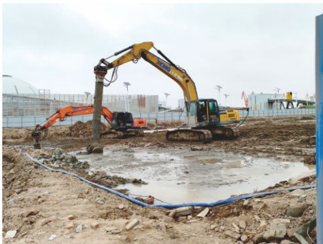
港口重型物料堆放场深层固化
