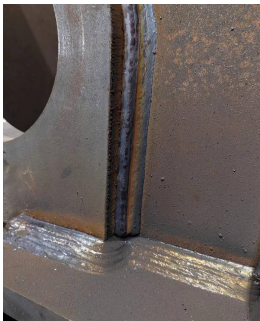
焊缝成型
