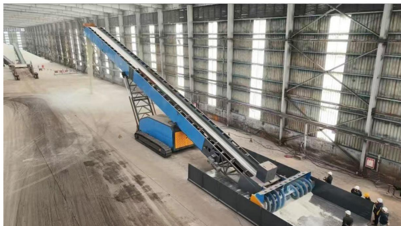
港口现场/PORT SITE
