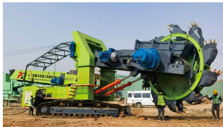
雄安土方现场/XIONGAN EARTHWORK SITE
