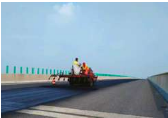
用于公路路面、桥面的养护
