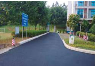
小区、园区内部道路的养护
