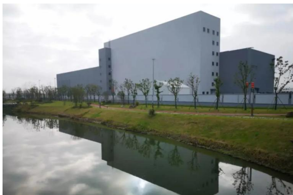
杭州路桥 安迈环保沥青搅拌站
