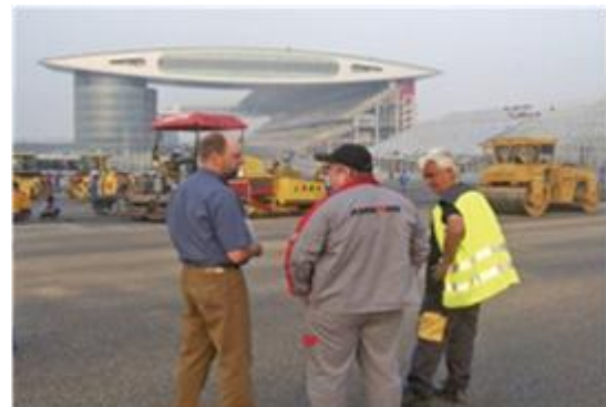
上海F1赛道施工现场
