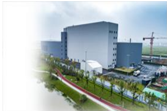
杭州路桥生产基地
