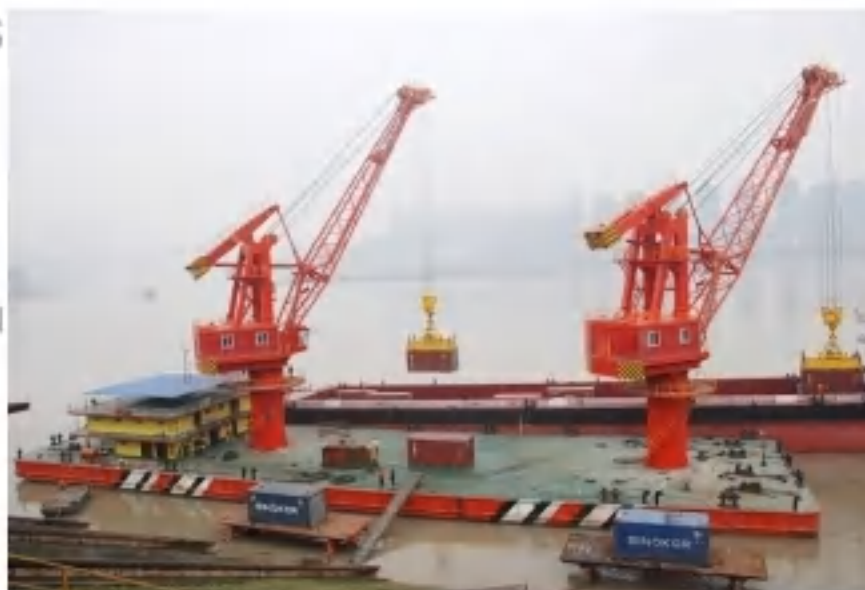
浮式起重机 float crane
