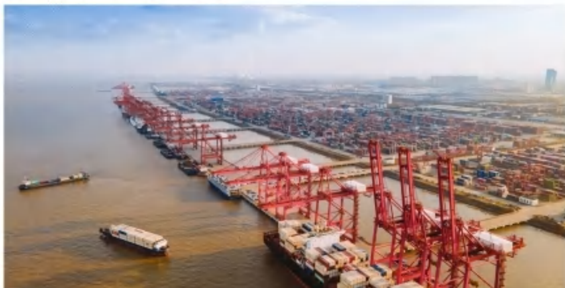
◆ 岸边集装箱起重机 Shore container crane
