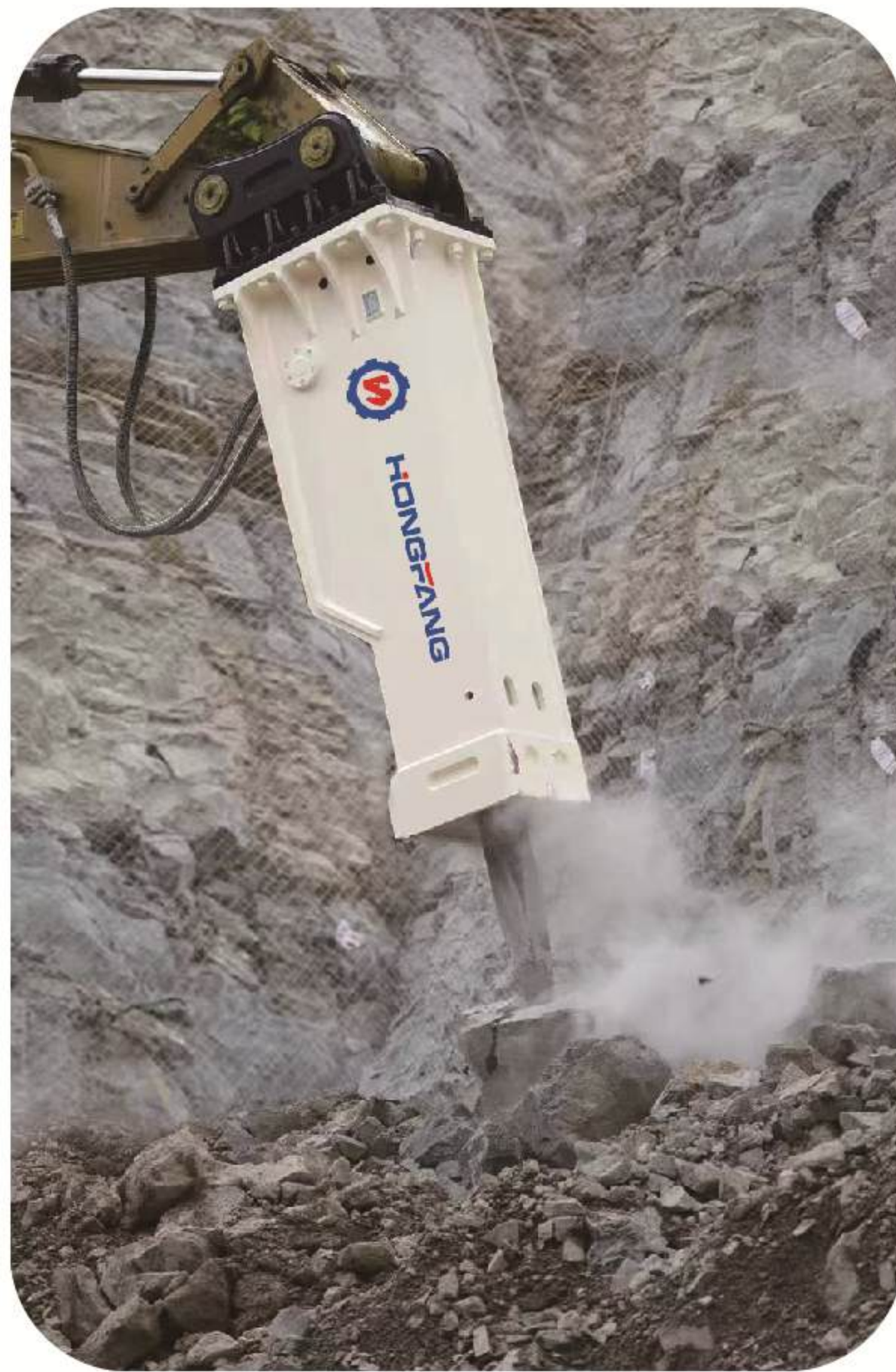
隧道作业 Tunnel Operation
