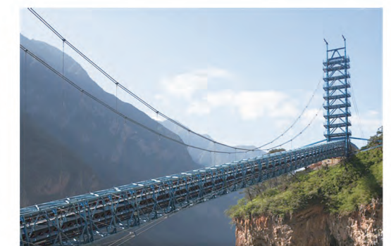
▲ 国家特高压输电工程皮带机项目 Belt conveyors system of UHV power transmission in China
