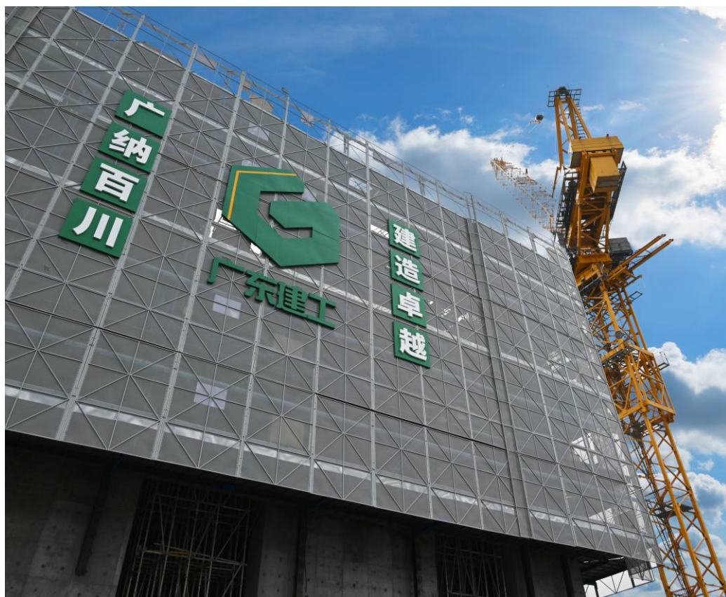
广东建工科创大厦项目
