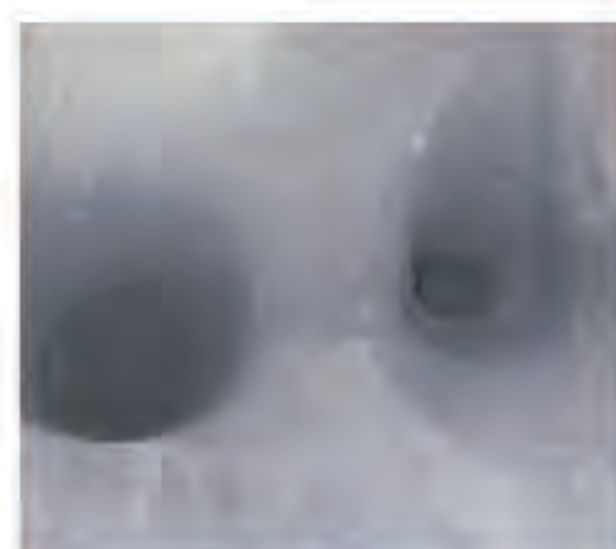
鼠洞状料仓内部
