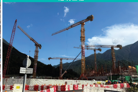
东涌第42区公营房屋发展计划的 建筑工程
