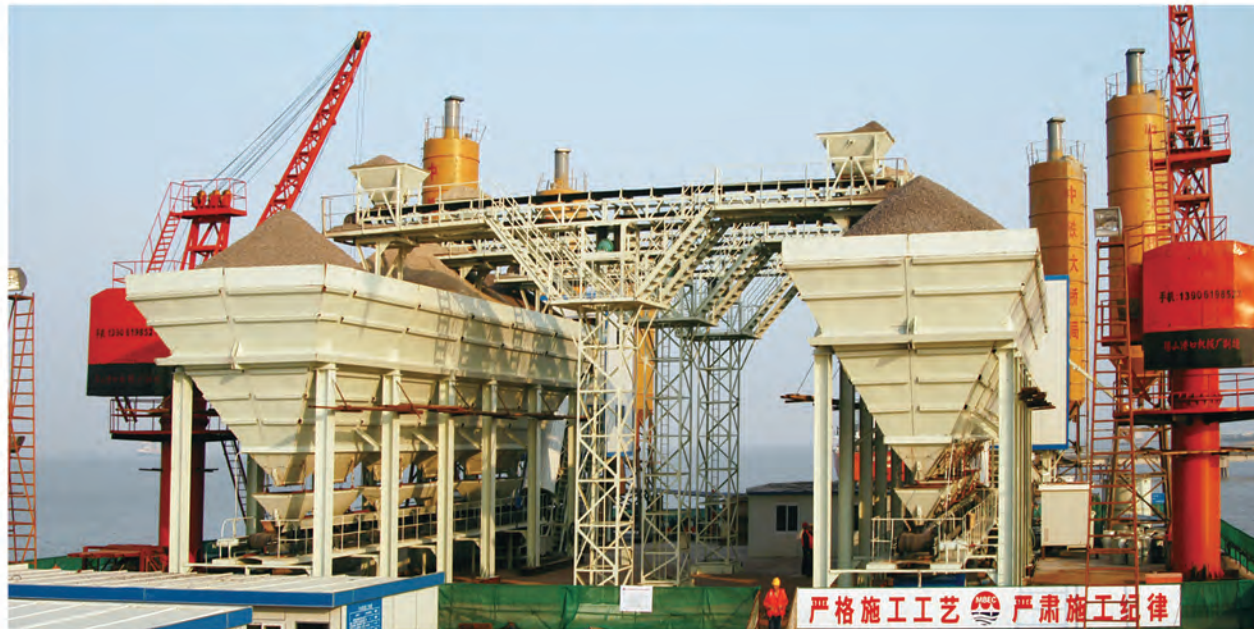
▲ 中铁大桥局水上平台特殊配料机
