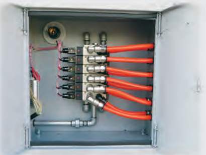
气路集中控制，防水、防尘，使用维护方便
