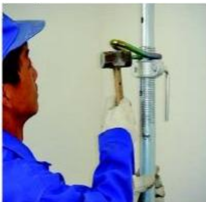
(7) 使用完毕，拆除独立钢支撑 Disassemble the steel prop
