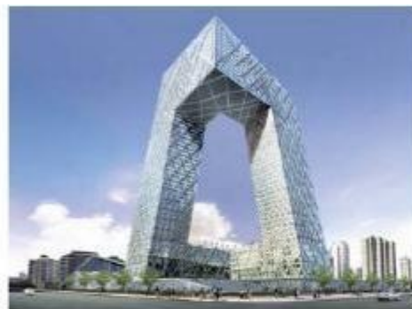
中国中央电视台新台址 New Site of CCTV
