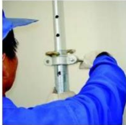
(2) 微调节螺母，使其达到使用高度 Adjust the swivel nut to an accurate height
