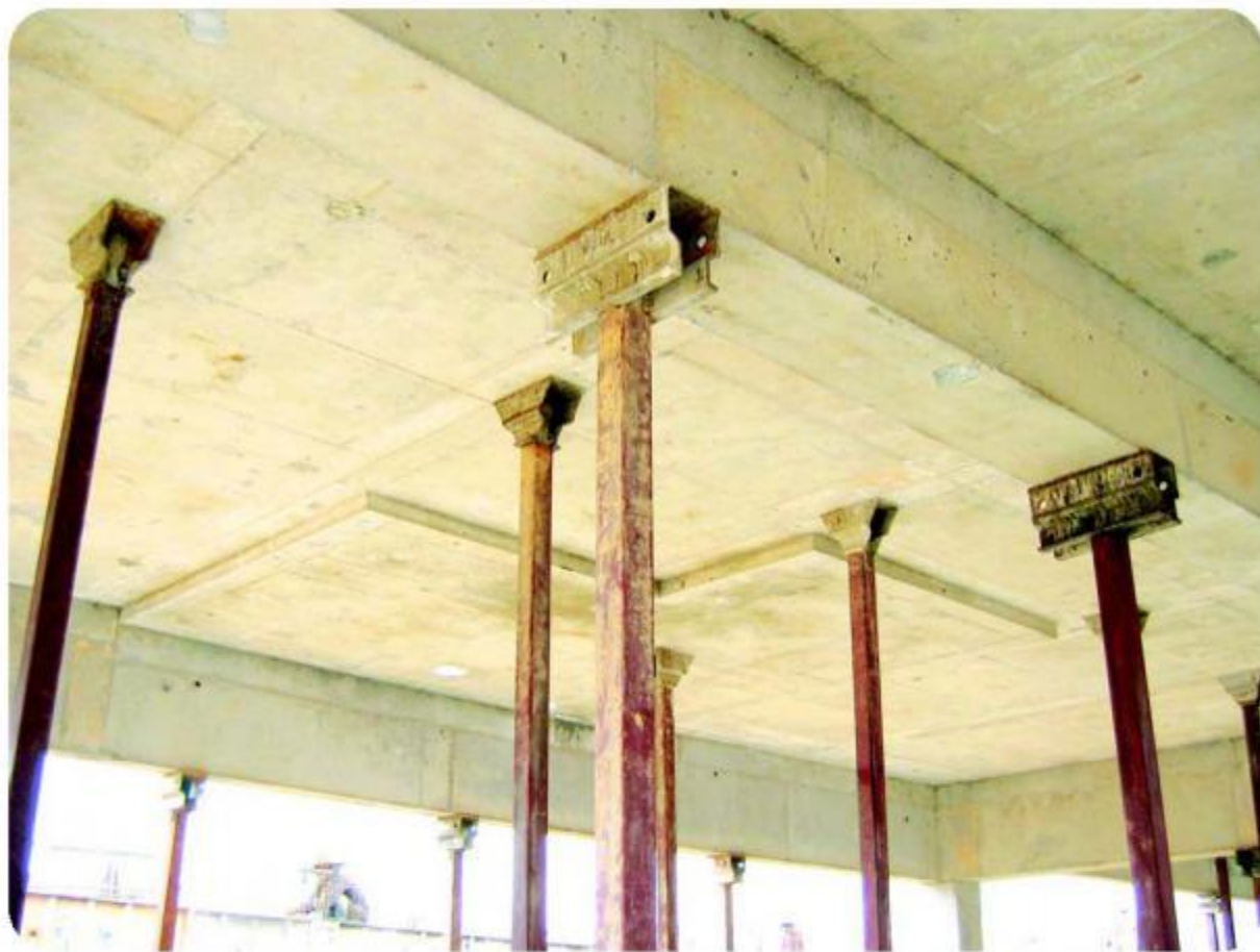
模板拆除后剩下晚拆头及支撑
