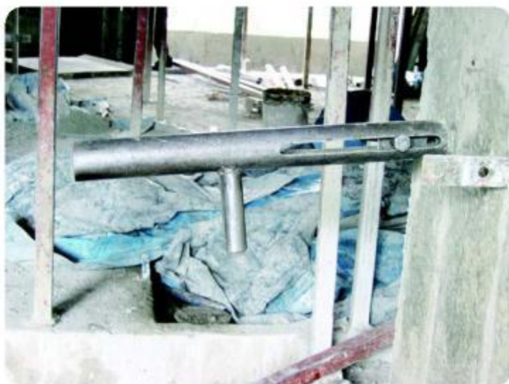
对拉板的拆除工具
