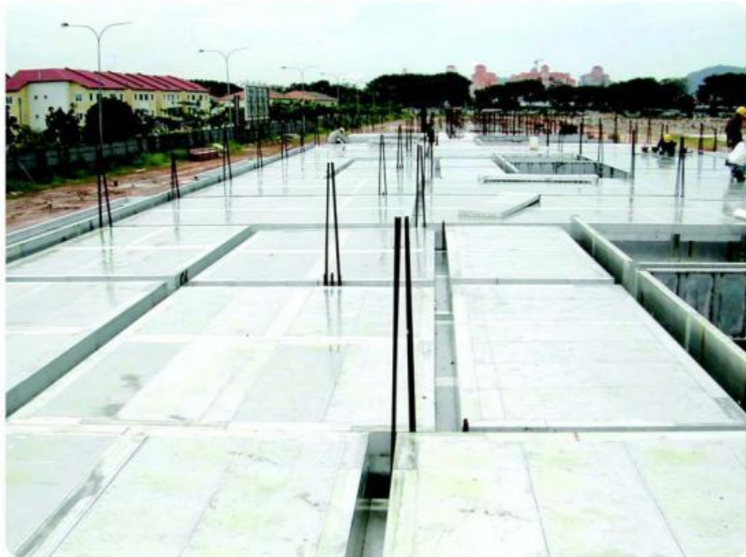
安装完成的模板
