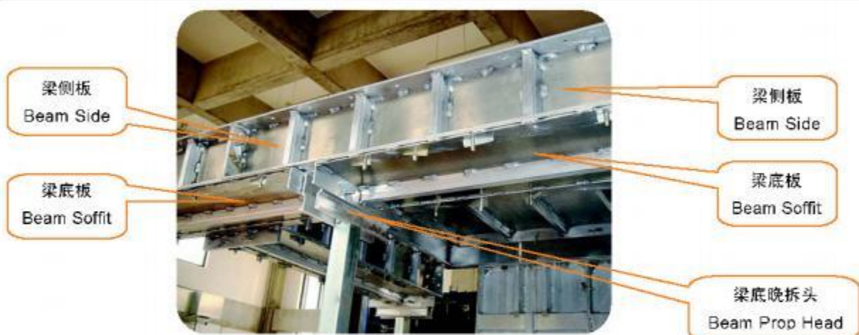
梁底晚拆支撑效果 The Use of the Beam Prop Head
