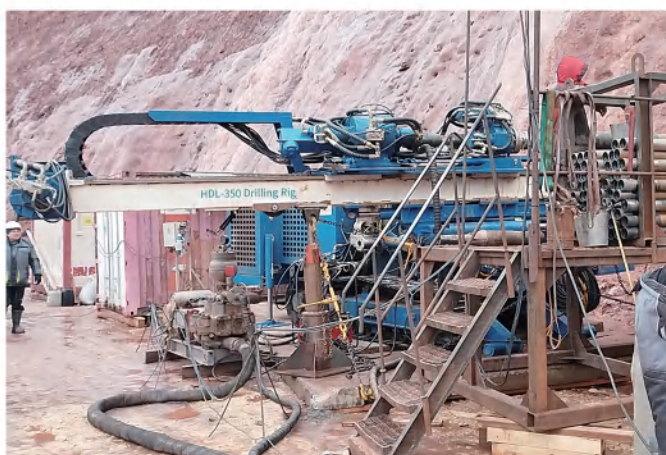
水平引孔施工 Horizontal Pilot Hole
