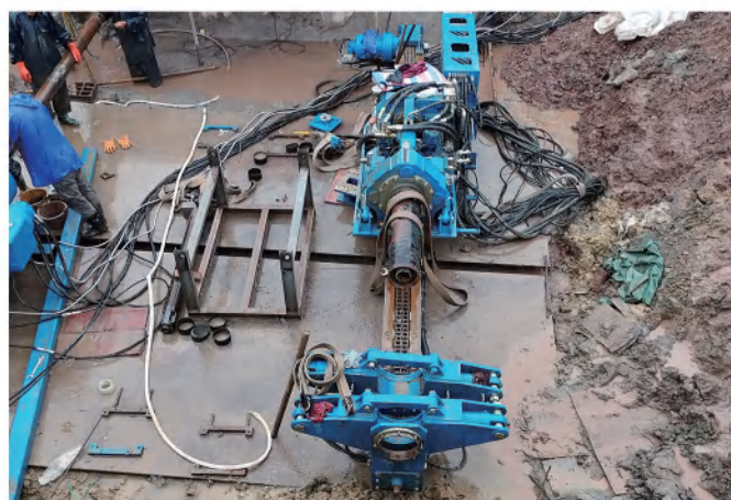
水平高精度引孔 Horizontal High-Precision Pilot Hole
