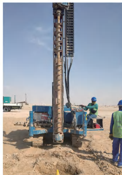
光伏桩施工 Solar pile
