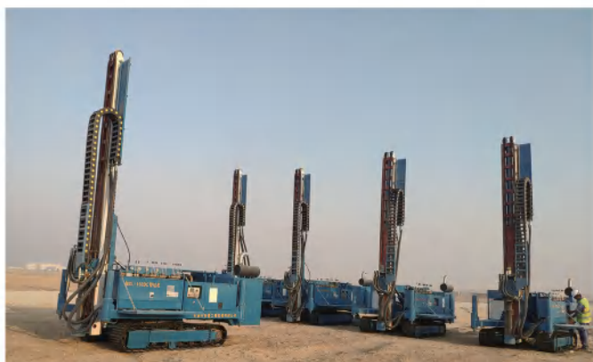
螺旋钻杆施工 Auger drilling
