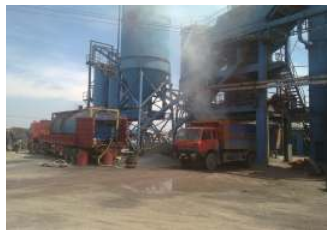
· 移动式沥青设备与拌合站对接 ·
