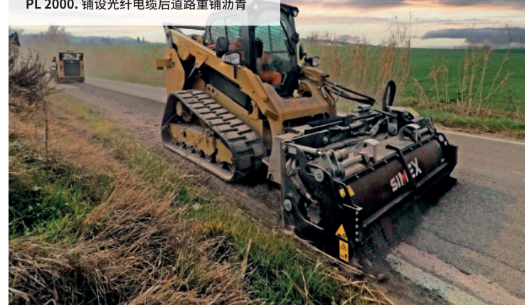
PL 2000. 铺设光纤电缆后道路重铺沥青
