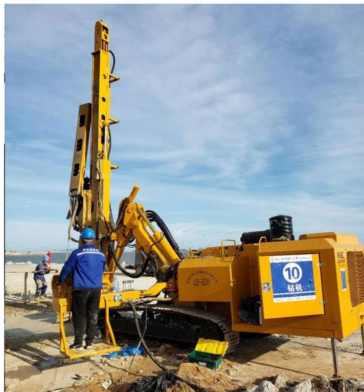
↑ 福建云霄核电围堰止水帷幕注浆引孔施工 ↑
