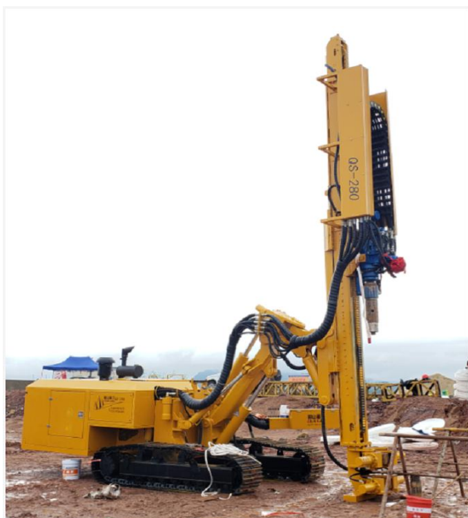
↑ 广东惠州大亚湾石化基地，填海造地 排水板引孔施工
