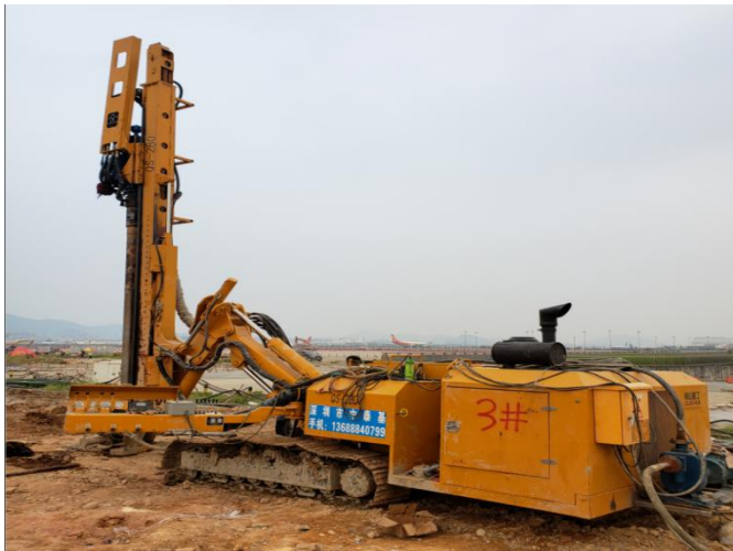
↑ 深圳机场扩建工程软基处理
