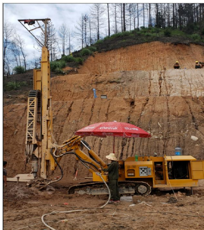
↑ 中铁二局兴泉铁路 QQXN-2 标隧道注浆引孔
