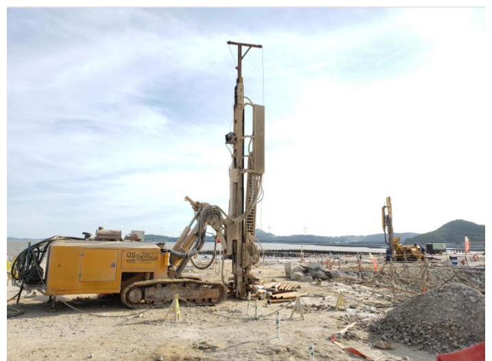
↑ 福建云霄核电围堰止水帷幕注浆引孔施工
