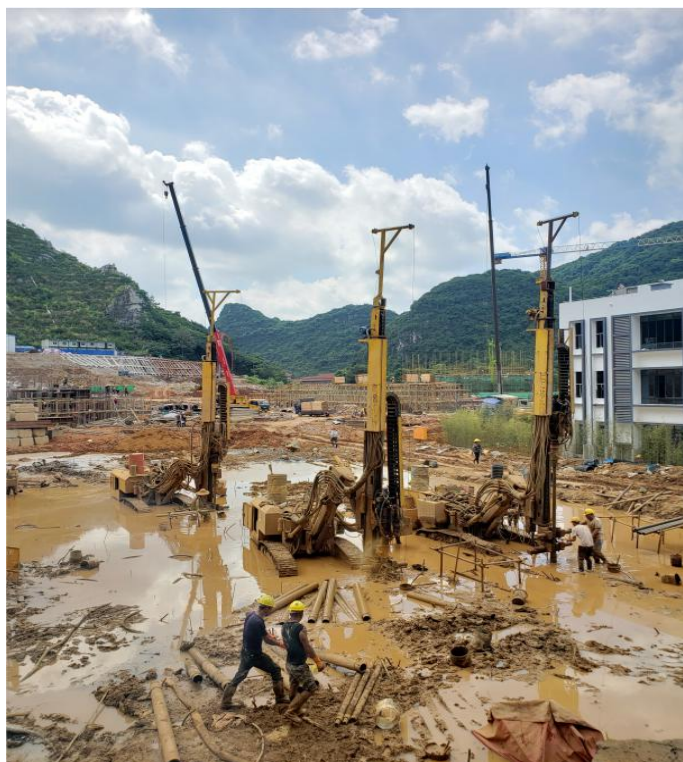
↑ 广西建工柳州工地抗浮锚杆施工
