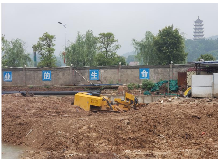
↑ 湖南省双牌县滨江明珠工地基坑支护锚索
