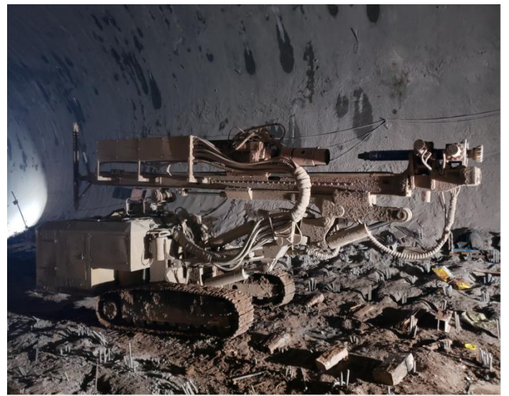
↑ 张吉怀铁路锚杆施工
