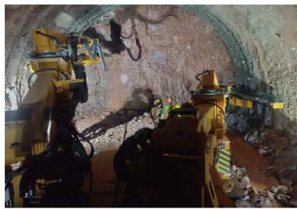
一次定位，无需移车便可完成 宽16m高11m隧道全断面施工
