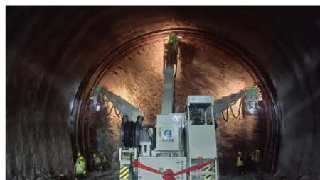
可全断面及台阶法施工
