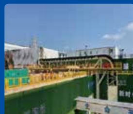
深圳地铁深惠城际大鹏支线
