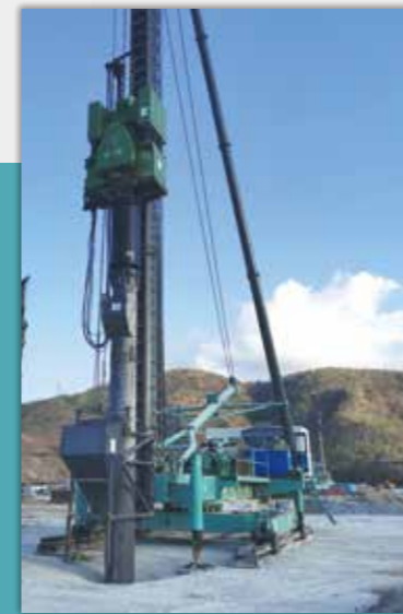
东帝汶集装箱码头碎石桩项目
