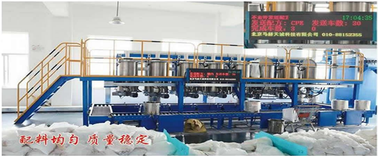
全自动化配料系统 Fully automated batching system
