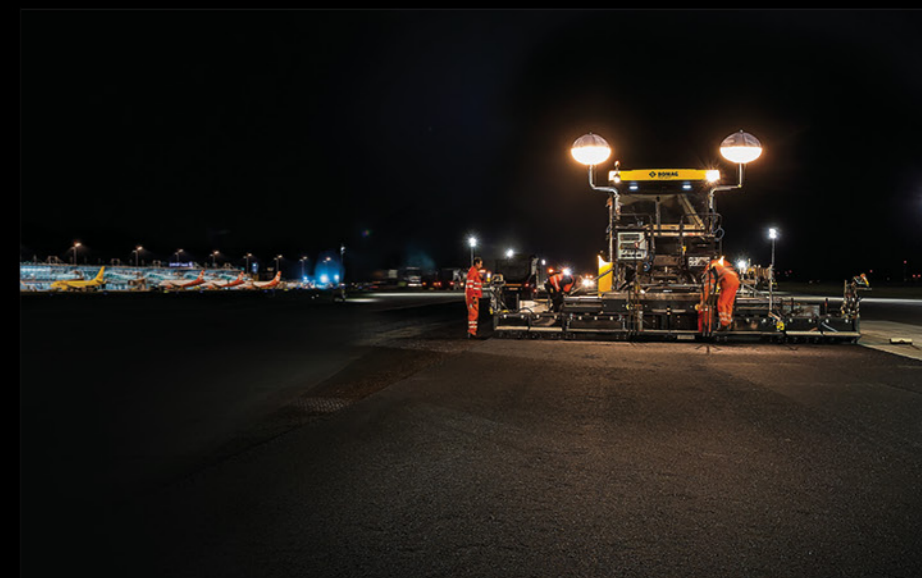
机场施工的夜间照明: 施工工期紧张时, 也能保证最佳的摊铺效果
