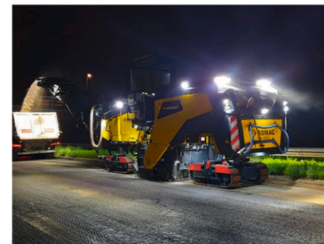
全方位的照明: BM58和BM68铣刨机配高级夜间照明套包, 在高速公路施工现场。
