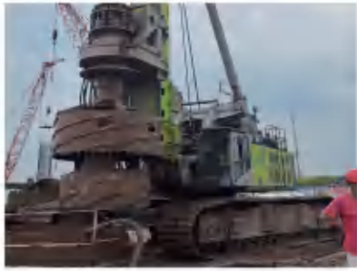
狮子洋特大桥梁项目 Lion Ocean ( Shiziyang) Bridge Super Project
