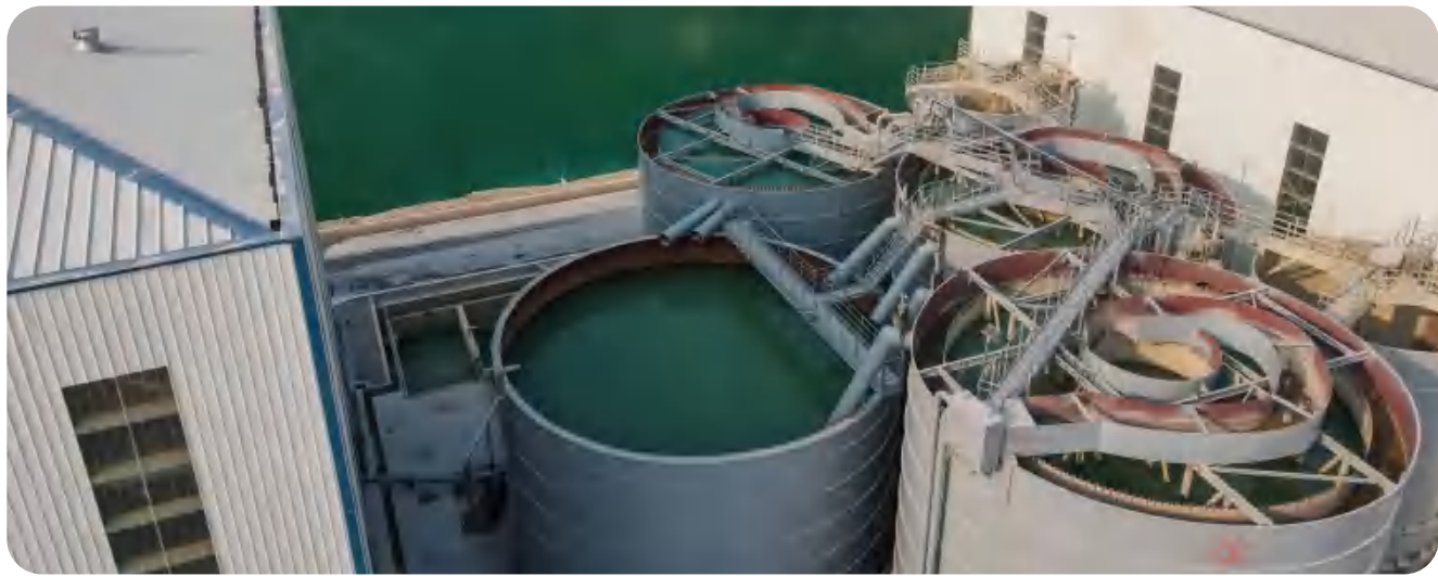
▲ 江门鸿盛石场2000m³污水沉淀系统项目
