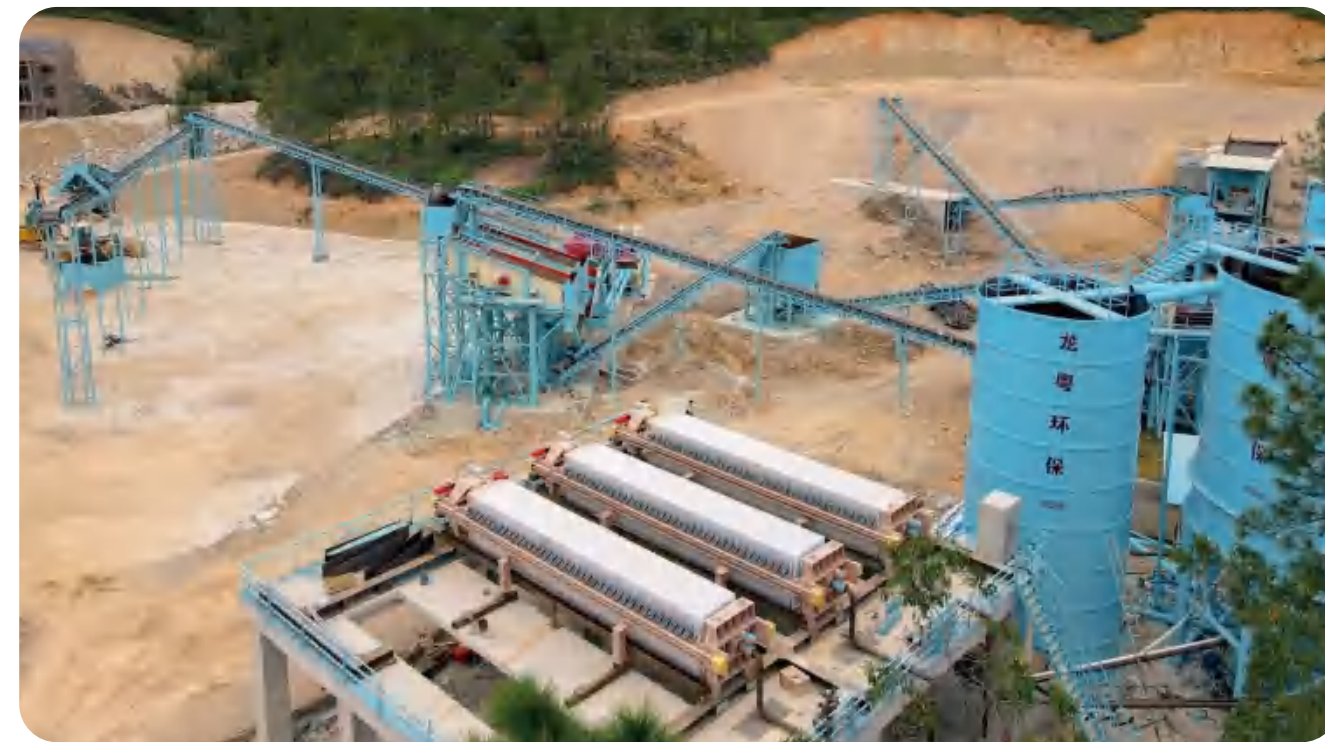
▲ 广东河源300tphEPC项目
