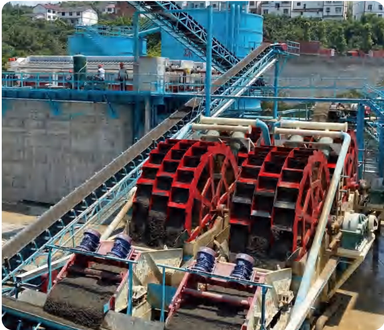
▲ 重庆350tph项目
