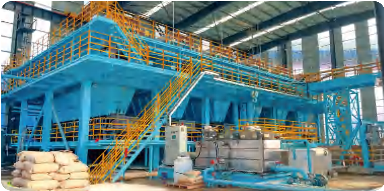
▲ 惠州新圩2500m³污水沉淀系统项目
