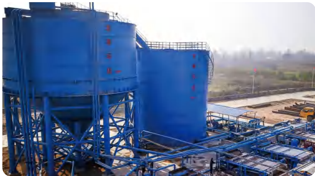
▲ 河南长城机械600tph项目
