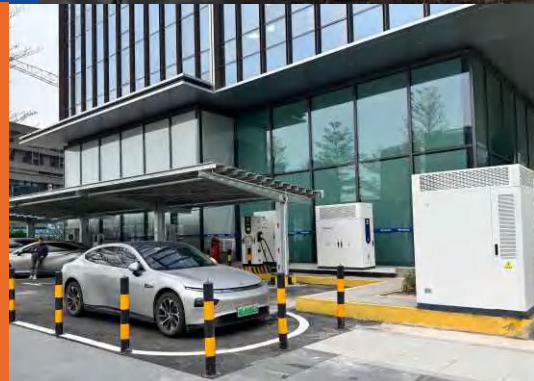
大亚湾光储充一体化示范项目 10台 120kW/215kWh 储能柜
