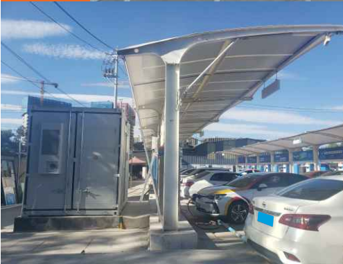
云能投光储充示范项目 250kW/120kWh 储能系统
