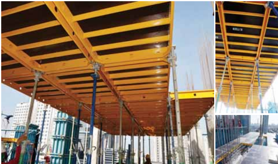
► Project in Malaysia
