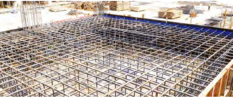
钢筋布局检测
