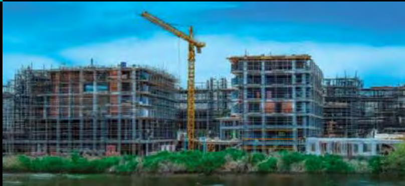
建筑工程与施工
