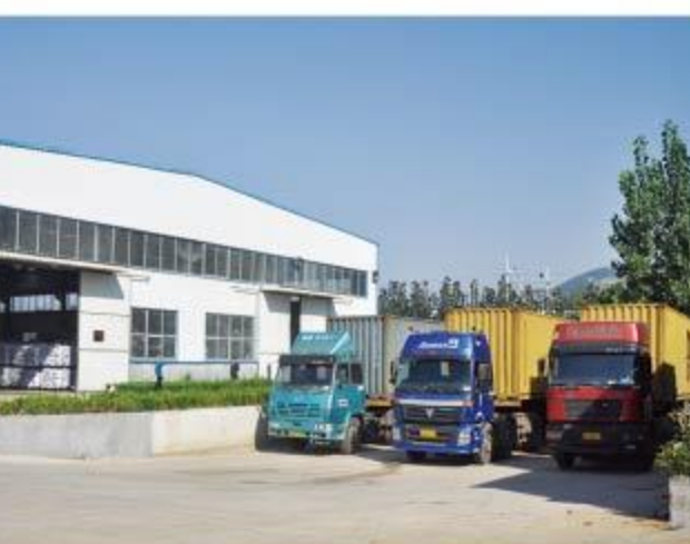
装箱平台 Container loading platform
