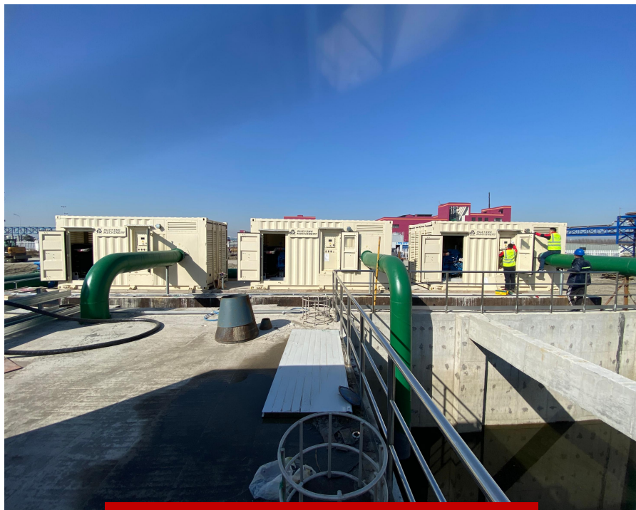
中石化防爆柴油机雨水泵站项目
