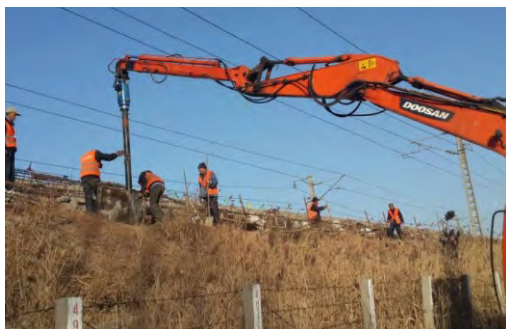
铁 路 电 力 钻 孔
