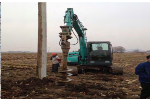
电 信 钻 孔
