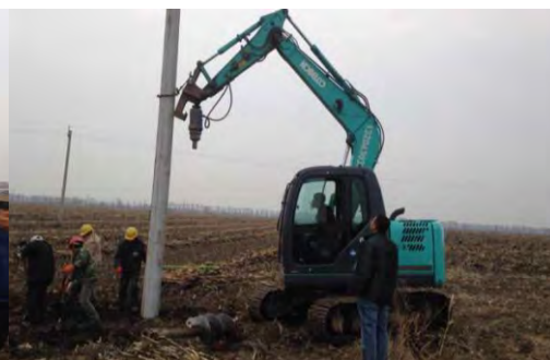
电 信 钻 孔
