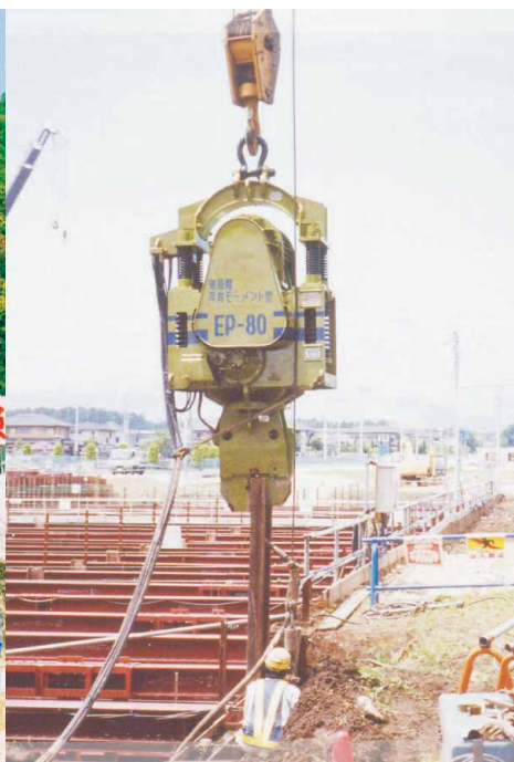
EP80免共振振动桩锤 日本川奈 Japan Kawana
