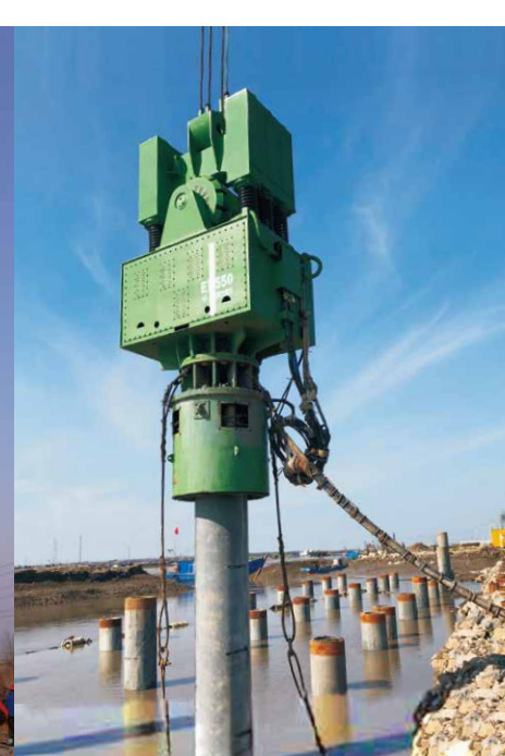
EP550免共振振动桩锤 中国天津 China Tianjin
