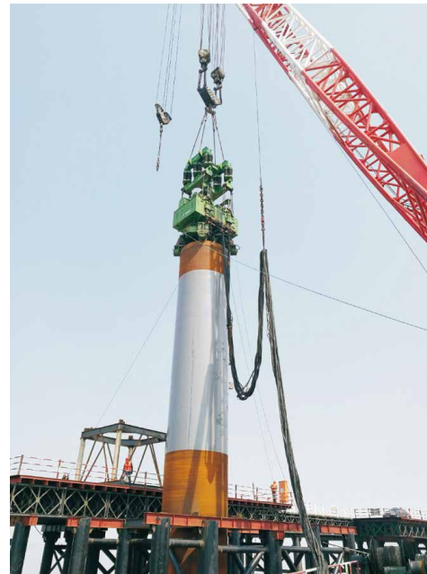
EP1300免共振振动桩锤 浙江舟山鱼山大桥项目 China Zhejiang
