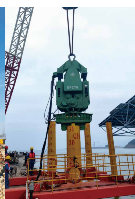
EP270免共振振动桩锤 中国福建 China Fujian
