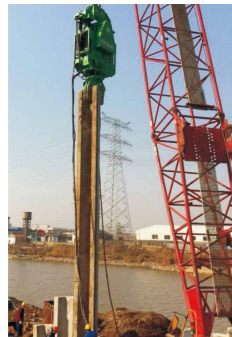
EP240免共振振动桩锤 中国镇江 China Zhenjiang
