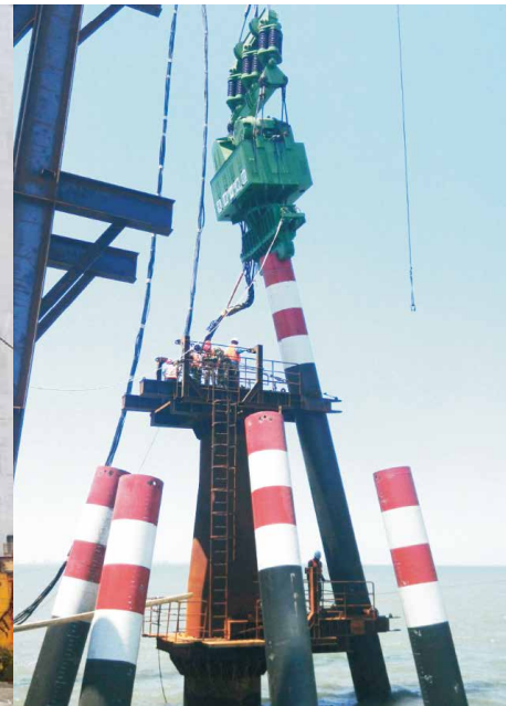
EP800免共振振动桩锤 天津滨海海洋生物监测平台斜桩项目 China Tianjin
