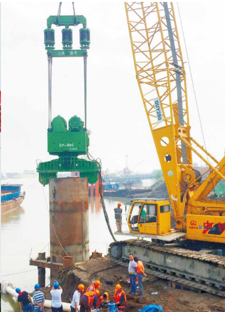
EP800免共振振动桩锤 武汉青山长江大桥项目 China Wuhan
