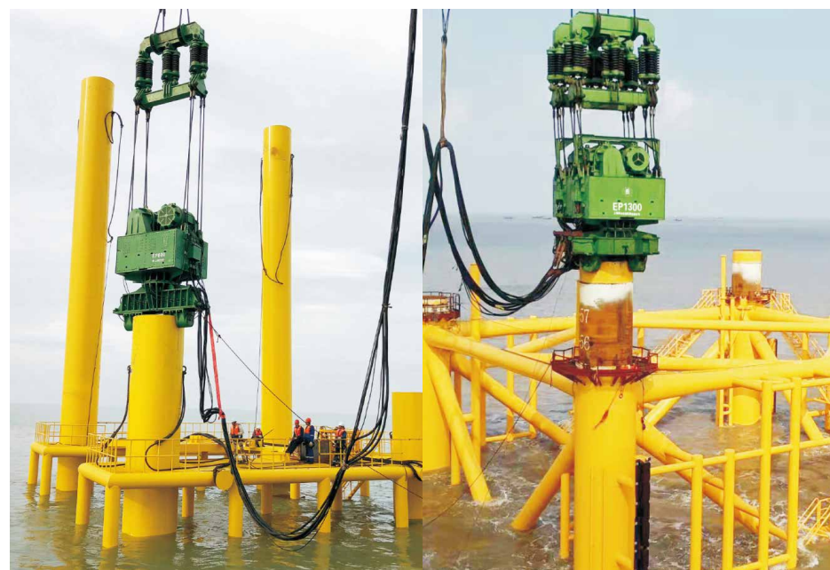
EP800免共振振动桩锤 江苏大丰龙源海上风电项目 China Jiangsu
