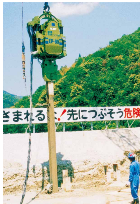
EP80免共振振动桩锤 日本长崎 Japan Nagasaki
