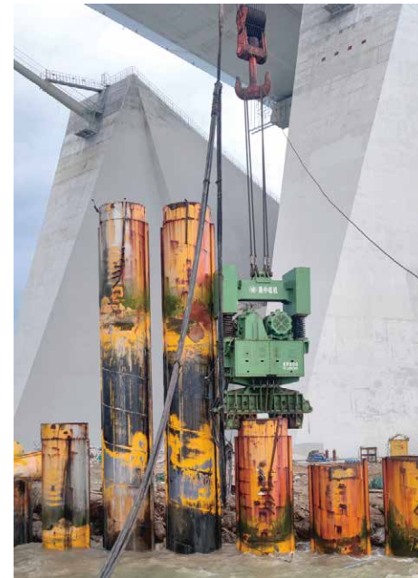
EP800免共振振动桩锤 深圳深中通道大直径锁扣钢管桩项目 China Shenzhen
