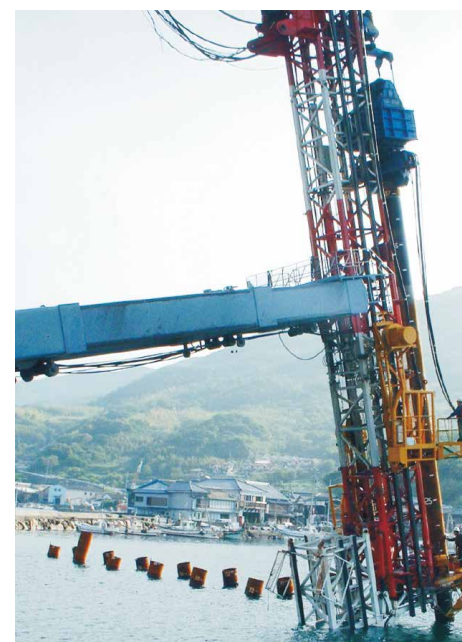
EP320免共振振动桩锤斜桩施工 日本九州 Japan Kitakyushu
