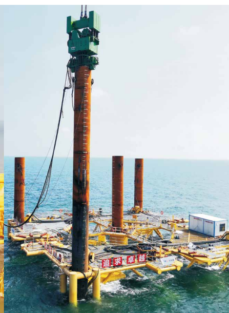
EP800免共振振动桩锤 广东南鹏岛中广核海上风电项目 China Guangdong
