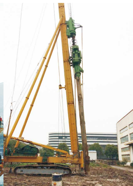
EP160KS免共振振动桩锤斜桩施工 中国上海 China Shanghai
