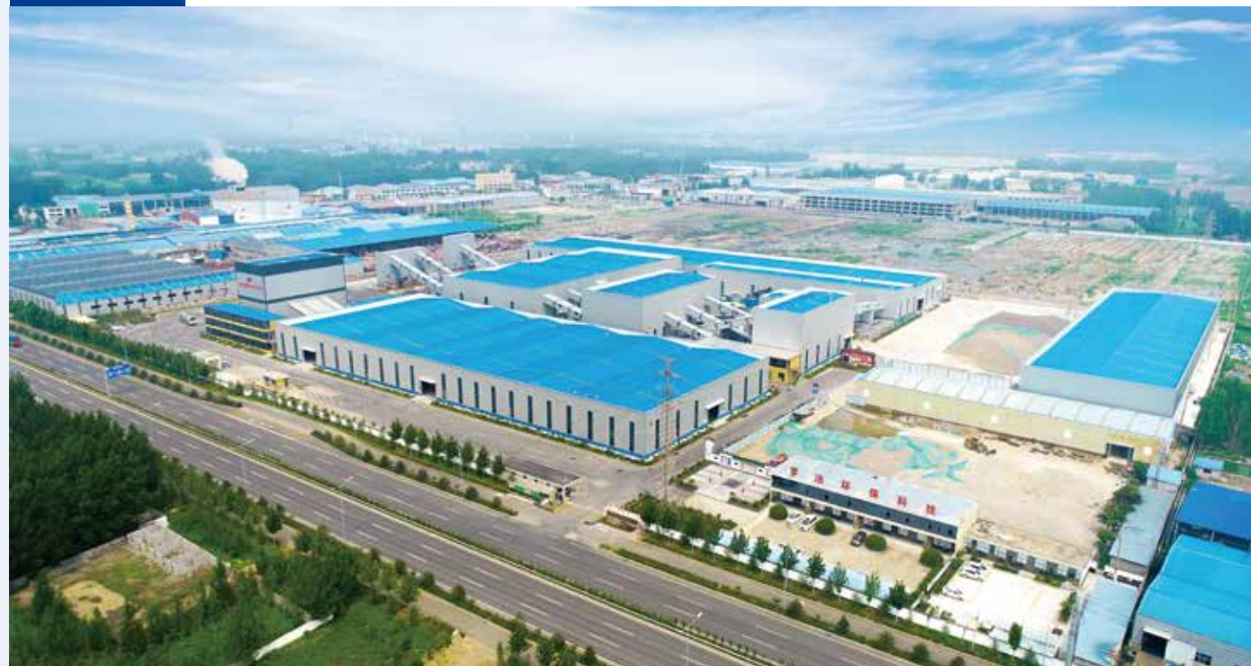
矿山废石&建筑固废循环利用、精品骨料生产产业园标杆项目
