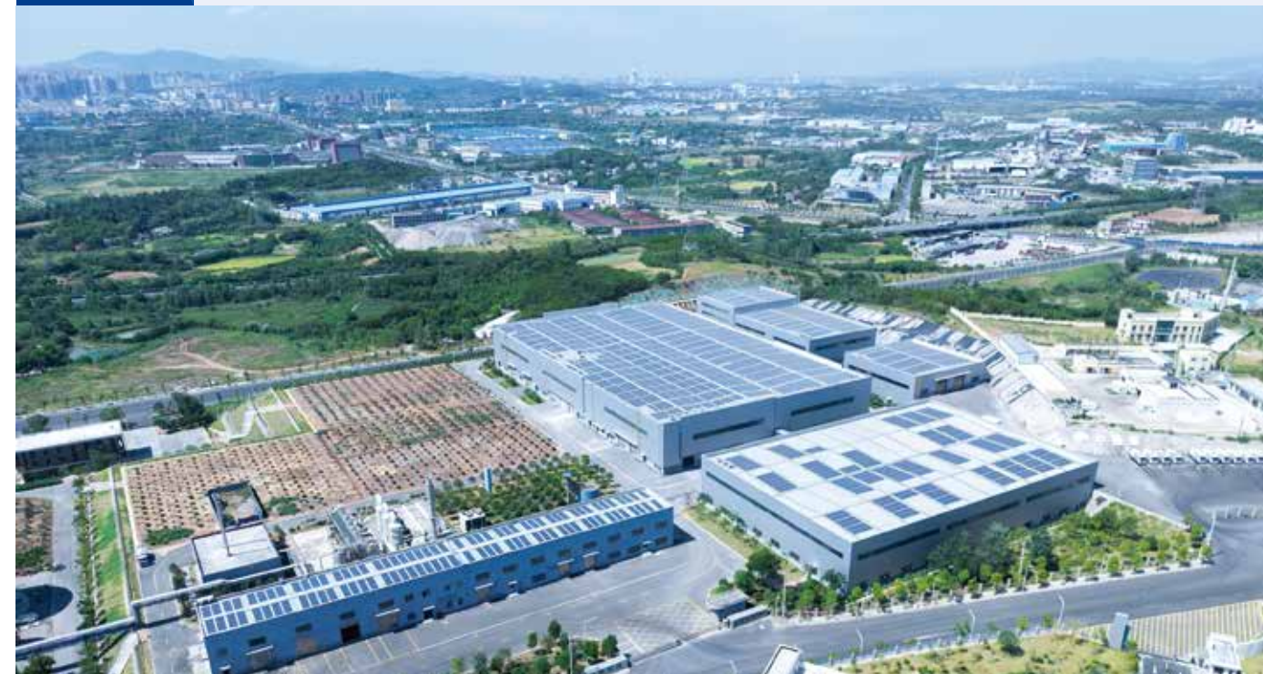
建筑固废处理静脉产业园项目
