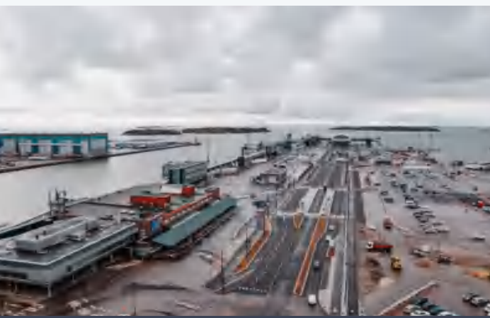
港口堆场维护
