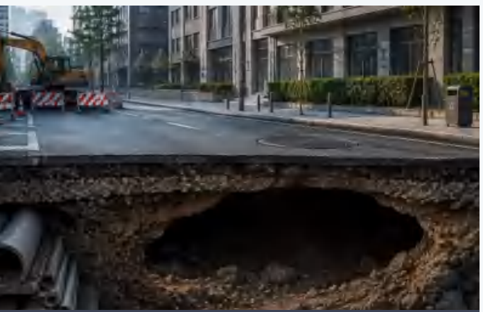
地下空洞探测
