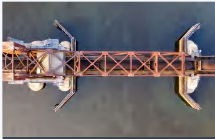
桥面铺装维修
