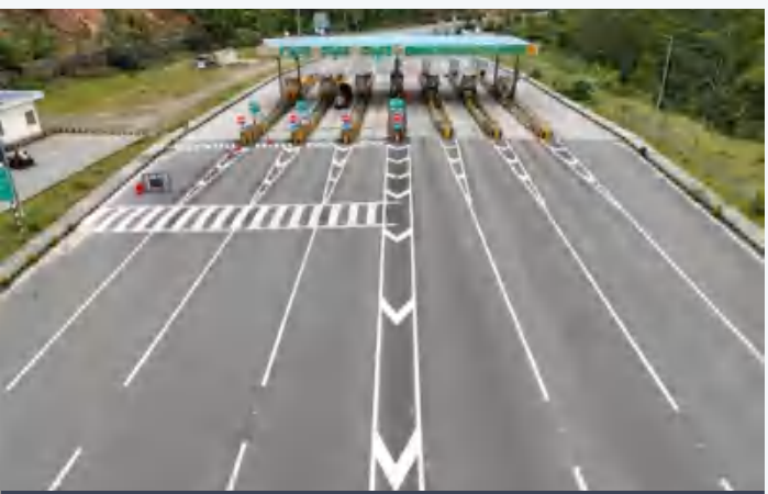
交通枢纽维护
