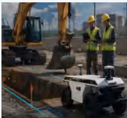
稳定控制高程、坡度与摊铺厚度
