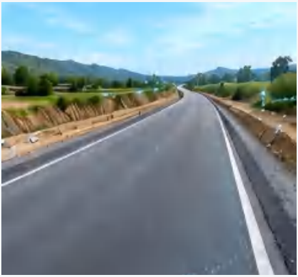
稳定控制高程、坡度与摊铺厚度
