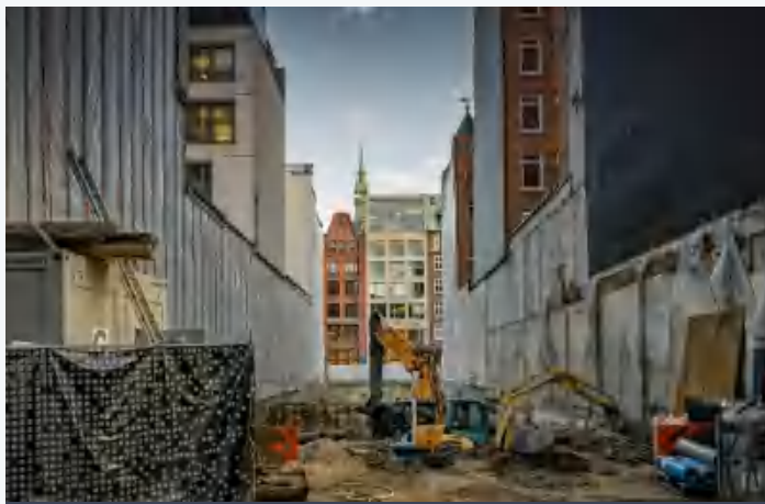
城市施工吊装
