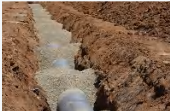
地下管线探测
