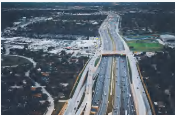
高速公路养护
