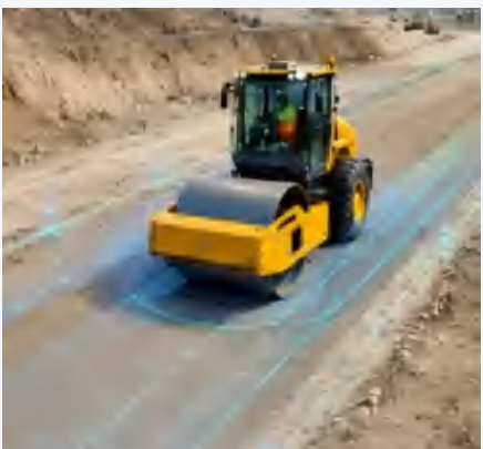
压路机轨迹跟踪
