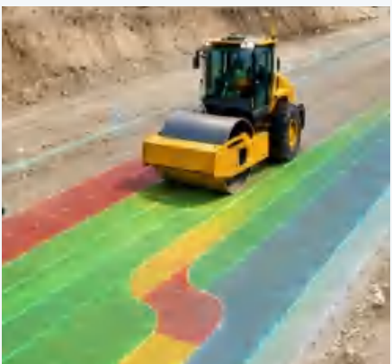
施工过程可视化
