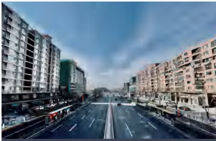
市政道路维修
