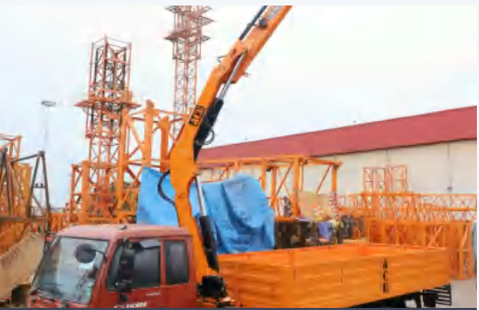
工业设备安装
