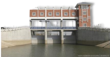
水电站闸门开闭控制
