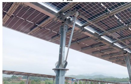
HB-DJ833K 机械连杆结构 德国, 20MW, 2024
