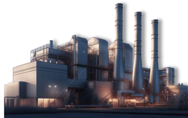
生物质发电厂原料输送系统
