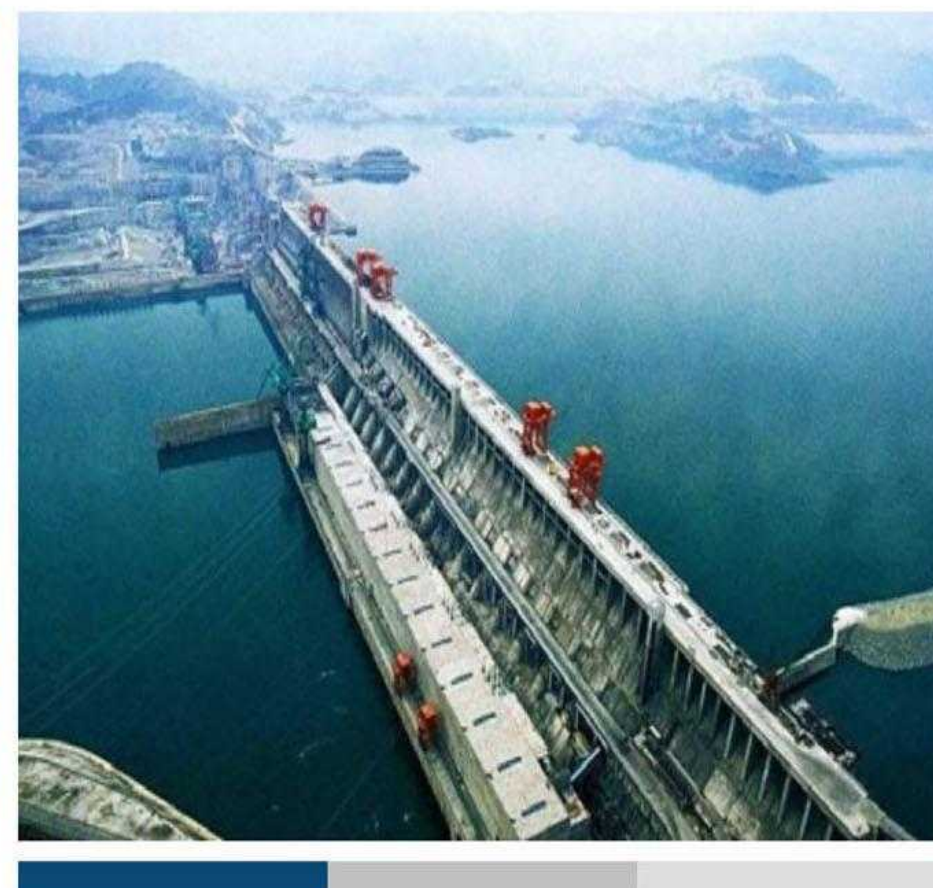
水利 Water conservancy
