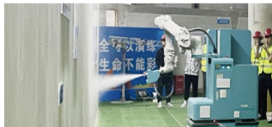
中建一局湖州奥青汇基础设施项目
