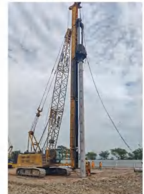
履带吊技改柴油锤工地施工案例
