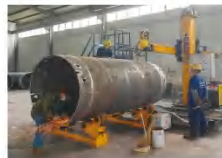
旋挖护筒生产 full casing
