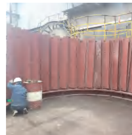
耐磨叶片 Classifier Blade
