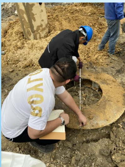
业务员技术人员前往工地，测量数据。
