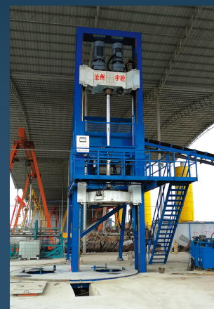
广西现场 Guangxi site
