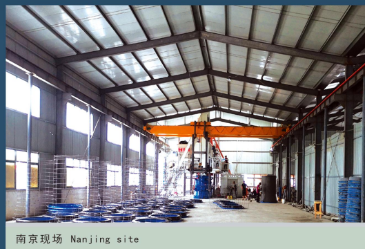
南京现场 Nanjing site
