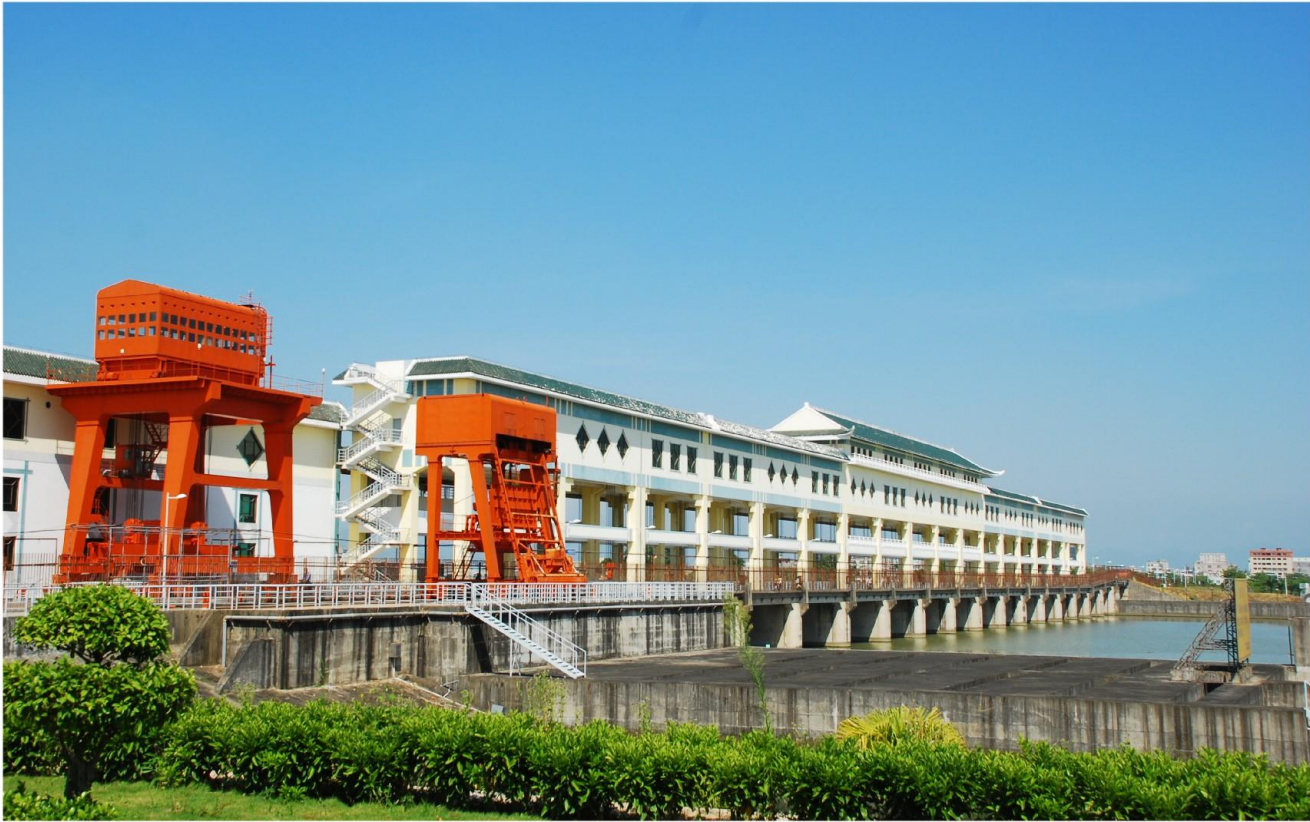
潮州供水枢纽工程
