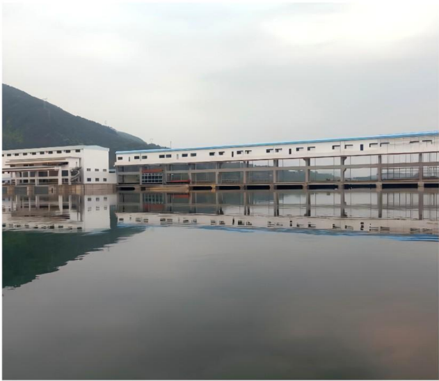
乐昌市张滩拦河坝重建工程
