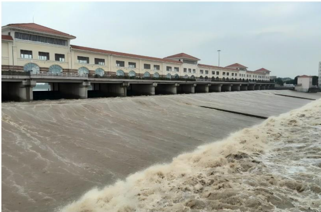
广州市李溪拦河坝工程
