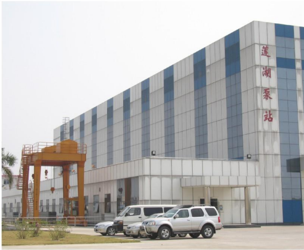
东深供水改造工程莲湖泵站
