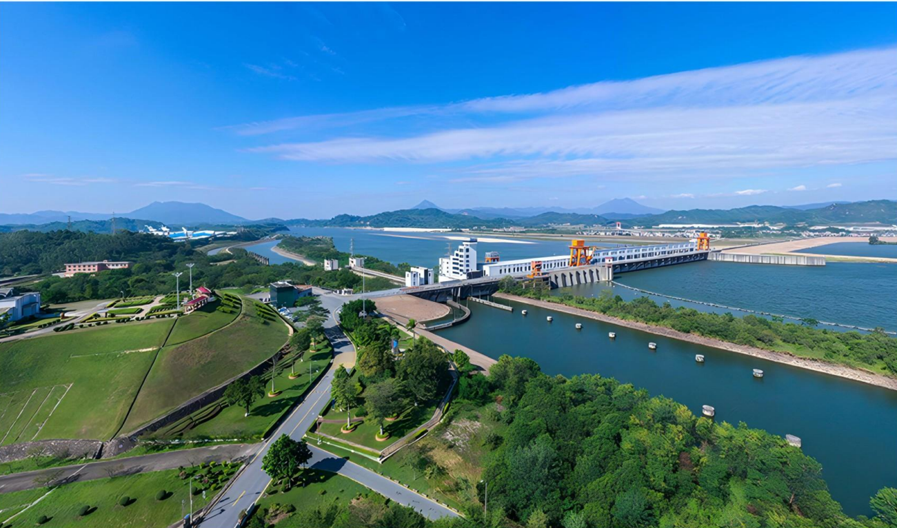
飞来峡水利枢纽工程
