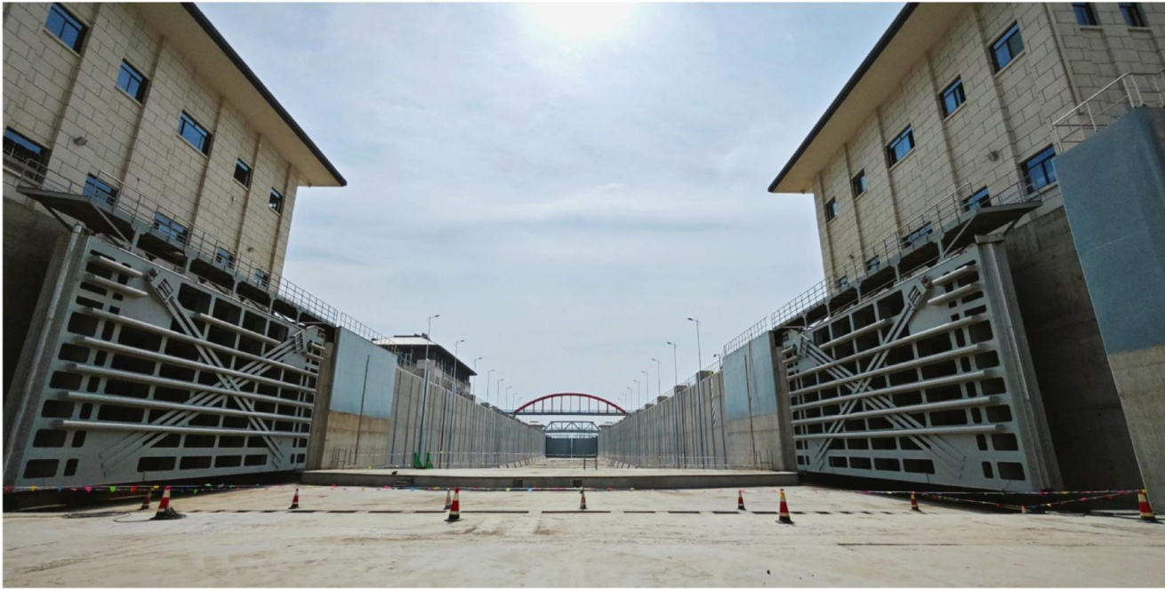
山东小清河复航工程
