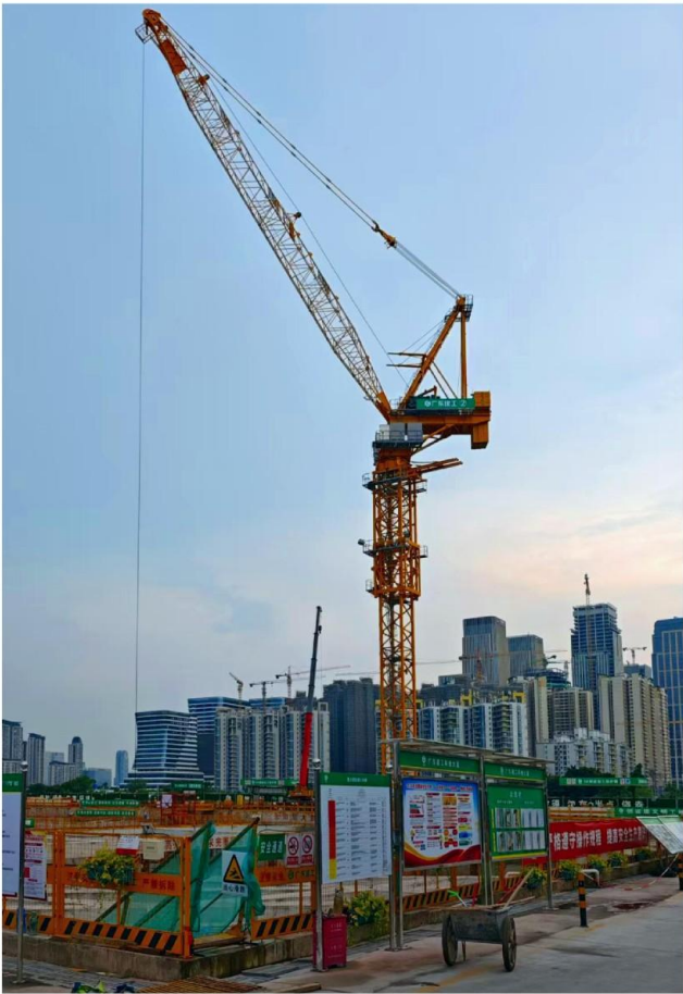
广东建工科创大厦项目现场塔吊应用
