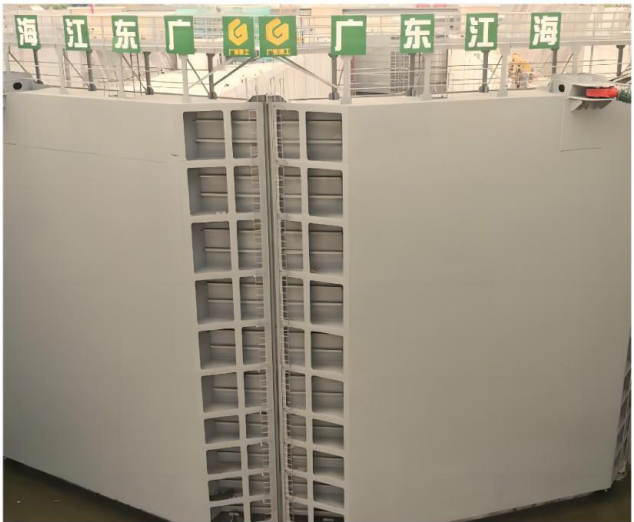
广东省最大的人字门(北江飞来峡船闸工程) 34m(宽)×19.67m(高)×3m(厚) 自重1103t
