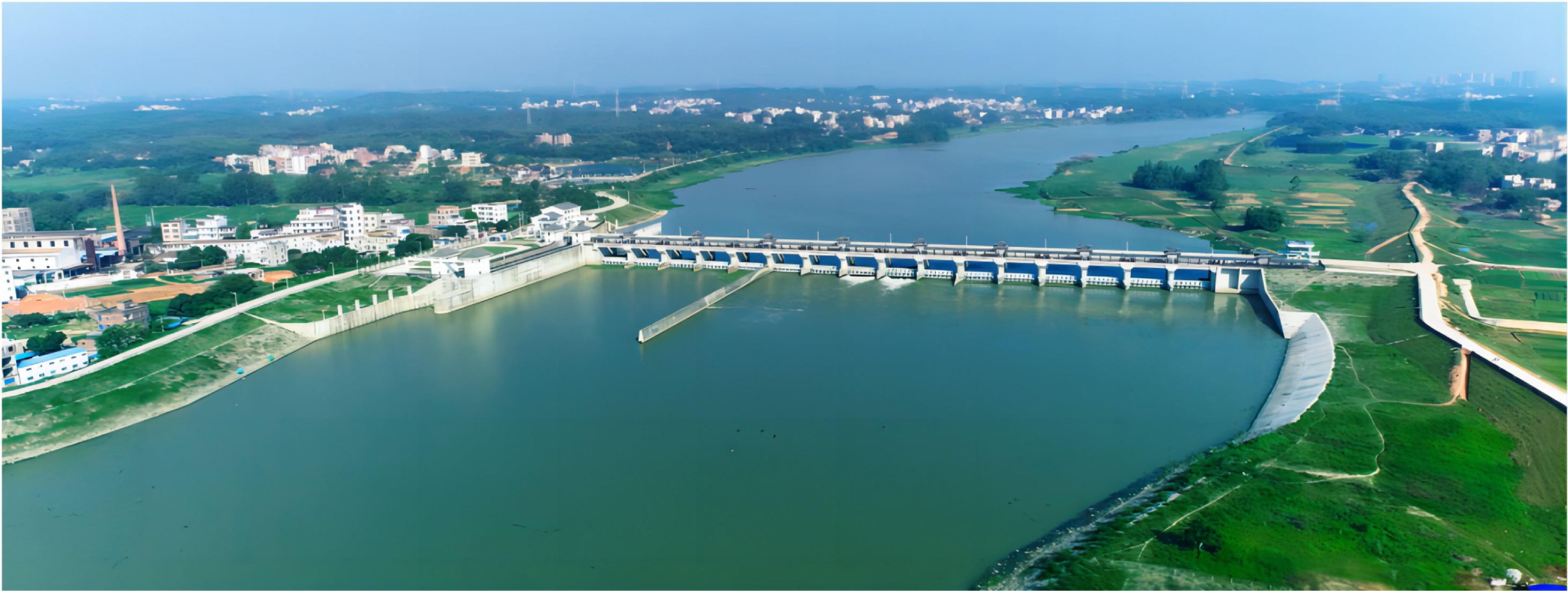
鉴江高岭拦河闸重建工程
