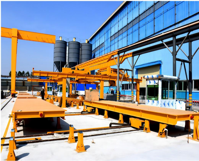
广东建远PC梁柱生产试验线(国内首创)
