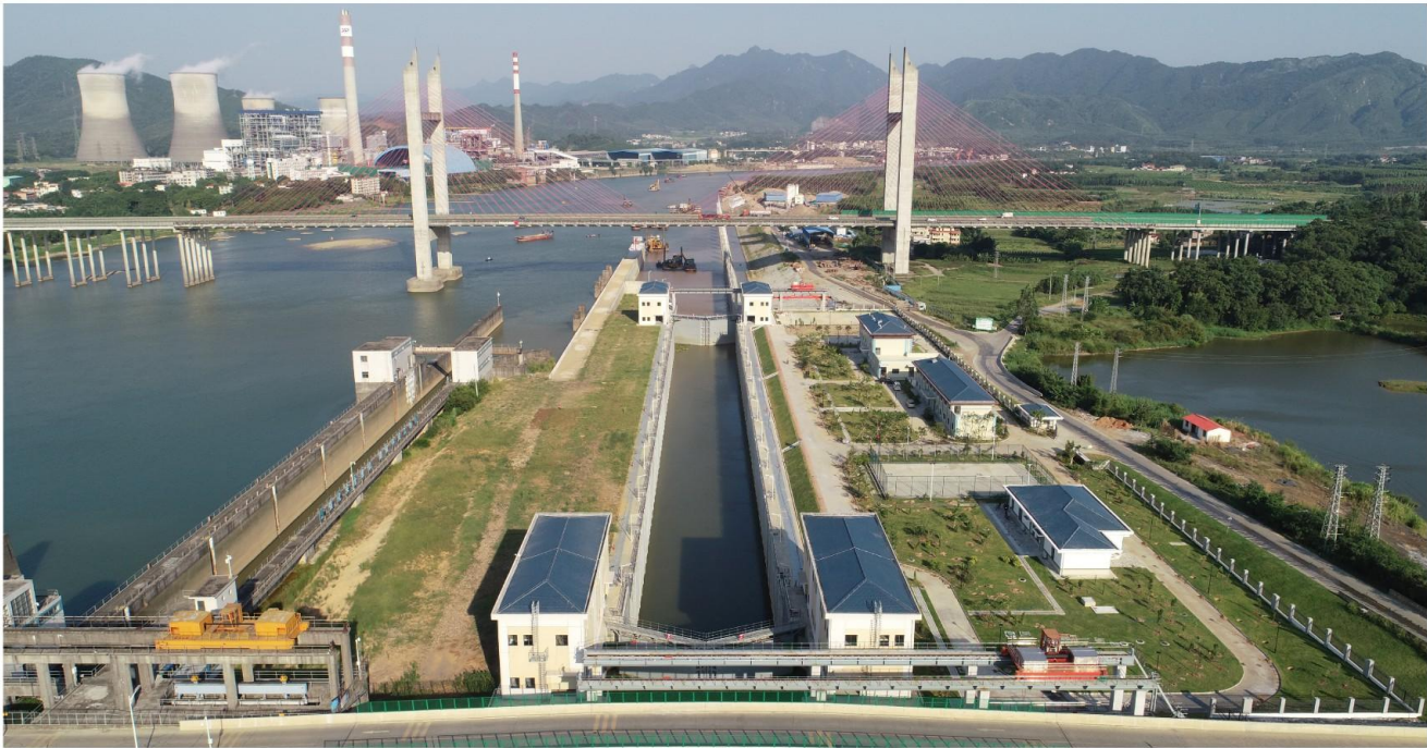
北江濠里二线船闸工程
