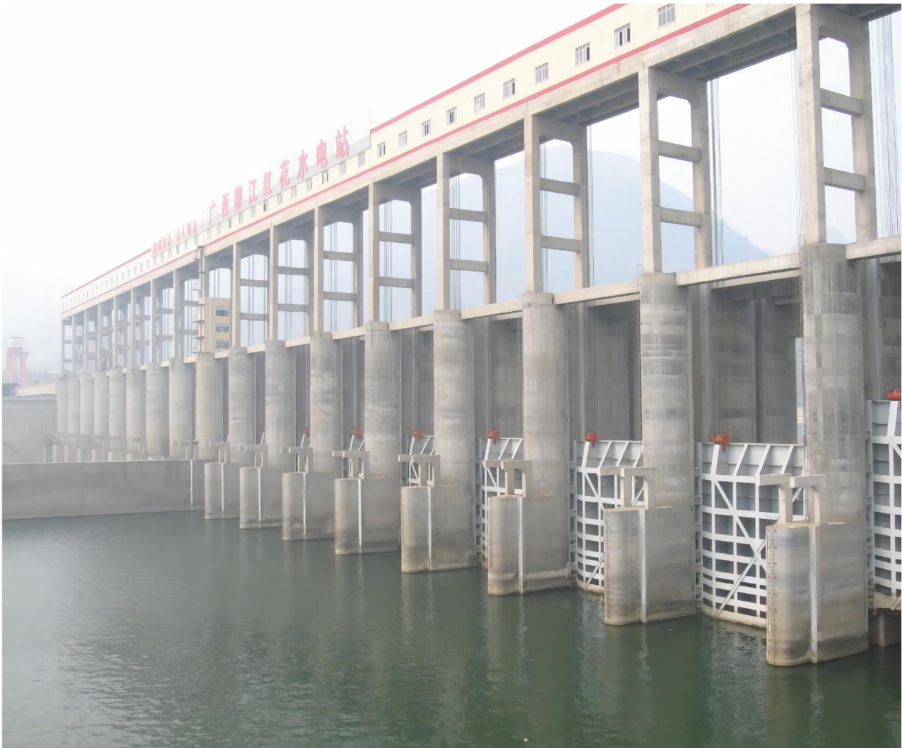
广西柳州市红花水电站泄水闸平面闸门
