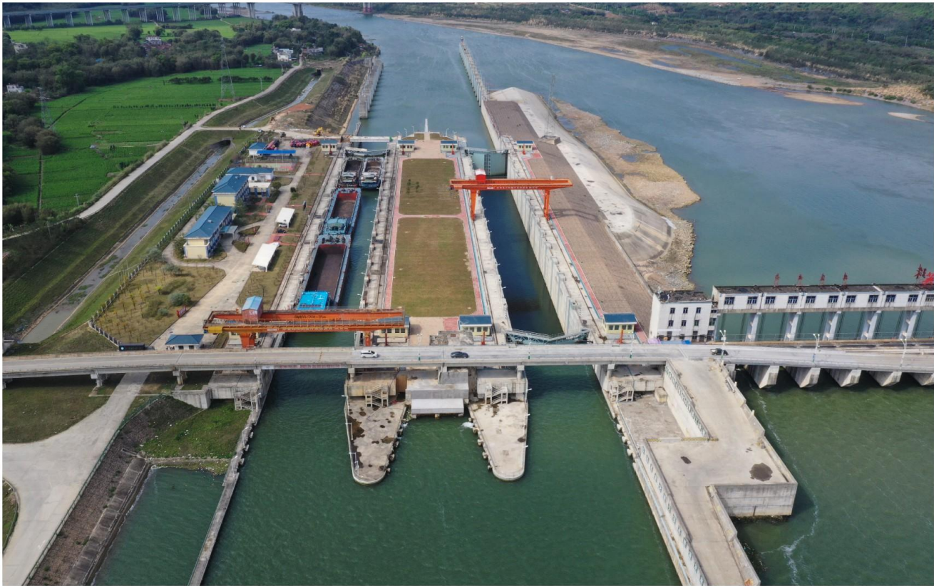
北江航道扩能升级工程白石窑枢纽一、二线船闸工程
