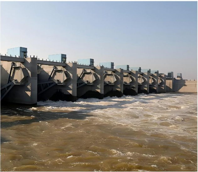
江西赣江新干航电枢纽工程
