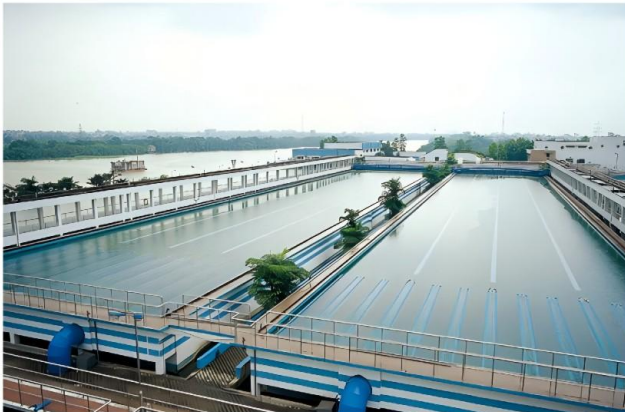
广州市西江引水工程
