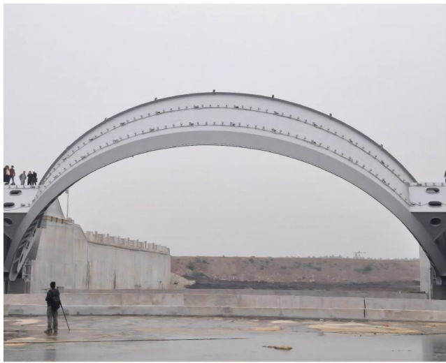
广州荔湾区花地河景观拱形闸门 (闸门高度6.19m,弧面长度46.8m)
