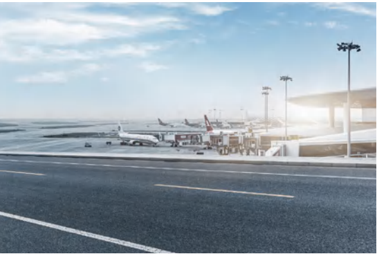
机场道路 AIRPORT RUNWAY
