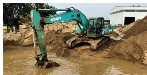
神钢260挖掘机配装ADI轴套挖沙作业
